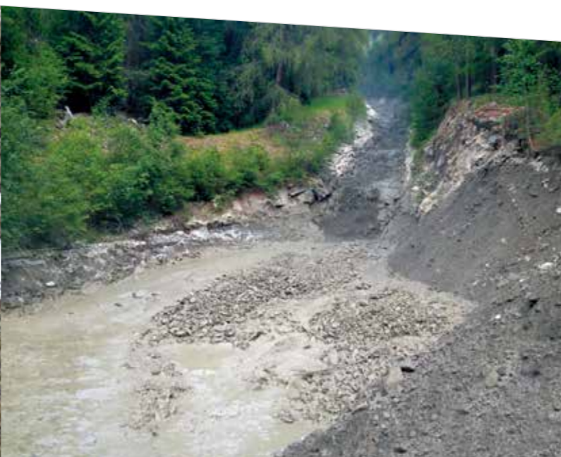
17.06.2013: arrivée d'une lave torrentielle dans le bassin de rétention déjà bien rempli
