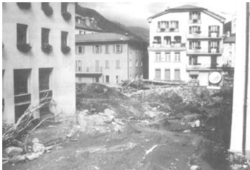
Photo 2. Débris déposés par la crue dans la partie supérieure de la ville de Brigue de la Saltina, à proximité du débordement du pont: quartier Marktplatz-Sebastianplatz. Les matériaux se sont accumulés jusqu'au niveau du premier étage des immeubles [photo OFEE, 25.09.1993].
