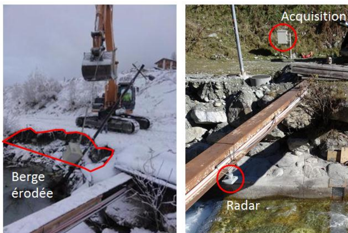
Figure 8 : Station expérimentale de mesure de charriage à Zinal (à gauche : travaux de réfection de la berge, à droite : nouvelle installation de mesure).
