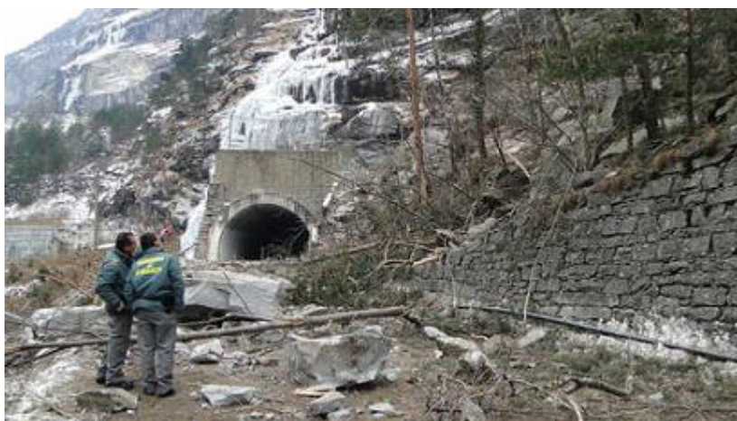
Figure 14 : Eboulement survenu le 4.1.2011 au portail Est du tunnel de Paglino (Iselle) © CREALP 2011
