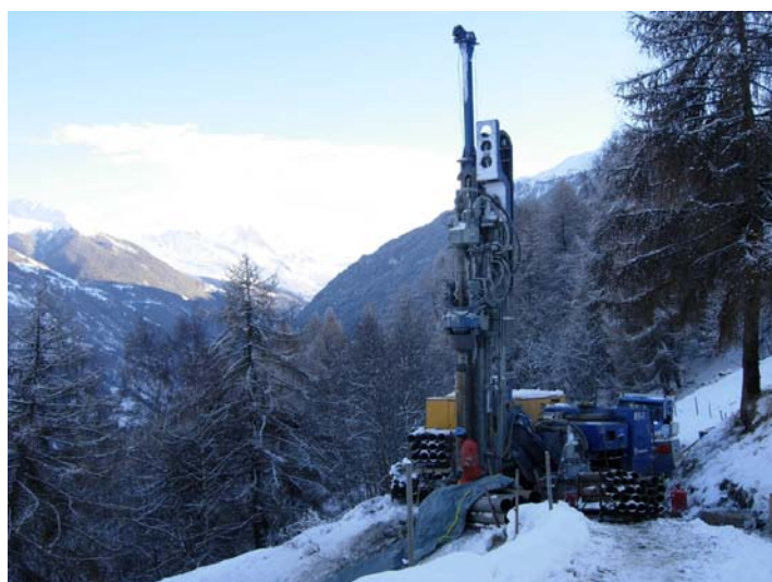
Figure 8 : Glissement des Masses – réalisation du forage SRCE à mi-décembre 2010
