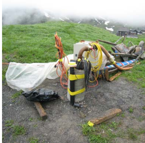
Figure 5 : Test hydraulique sur F01-07 à Mirois
