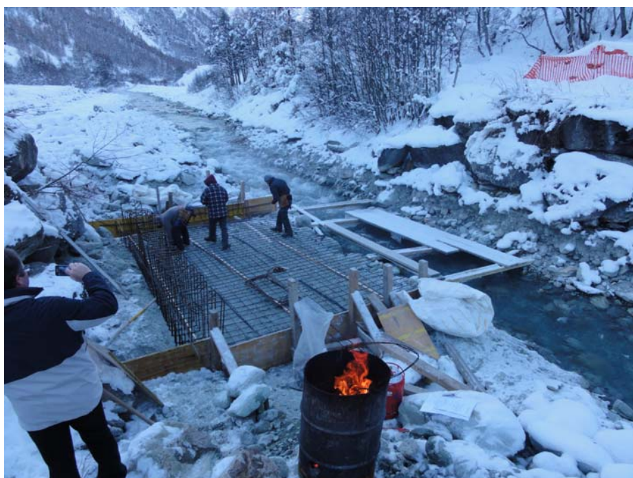
Figure 13 : Construction de la station de mesure de débit dans la Navizence
