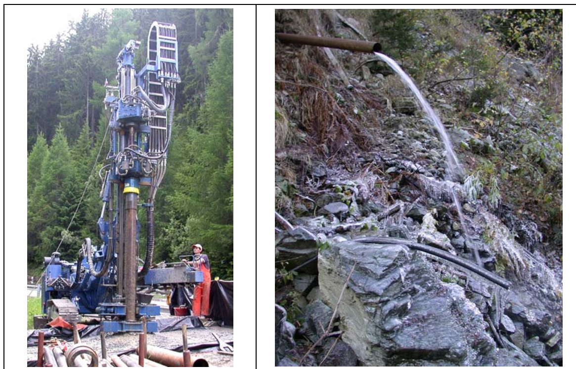
Figure 3 : Forage de reconnaissance et drain foré réalisés au Pont-du-Bois. Le drain a été implanté en dessous de la RC à partir des berges de la Navisence [© CREALP 2009]
