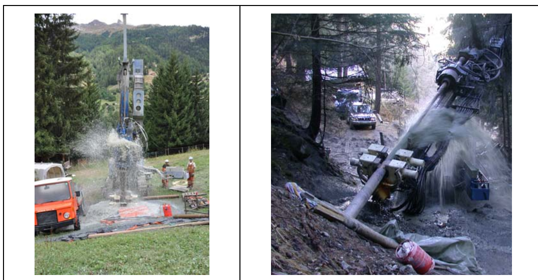
Figure 5 : Glissement des Morasses d'en Bas : le forage F2 et le drain DF3 au moment où ils touchent l'aquifère artésien [© CREALP 2009]
