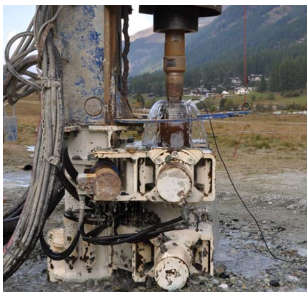
Figure 9 : débordement artésien du forage du Plat de la Lé [© CREALP 2009]
